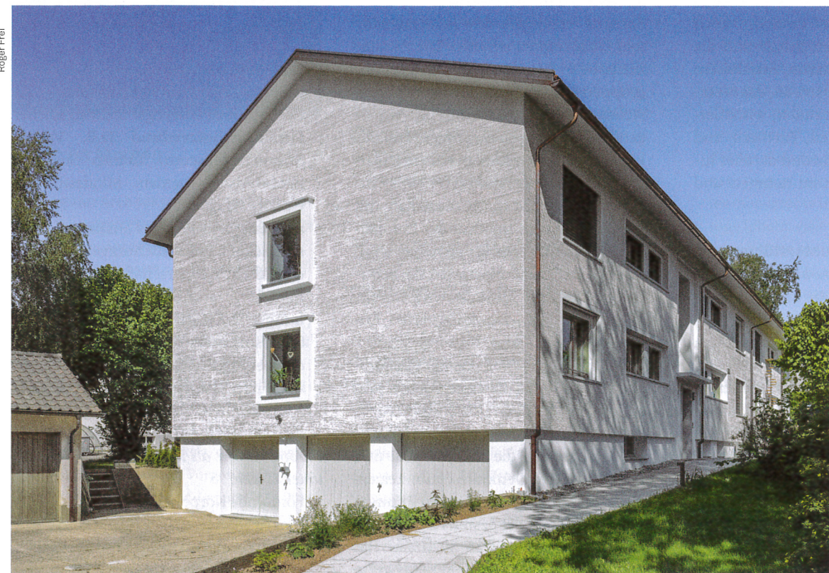
Die Gebäudehülle des Wohnbaus in Aarau wurde komplett saniert: neue Fenster, ein neues Dach und 20 Zentimeter mineralische Aussendämmung.
