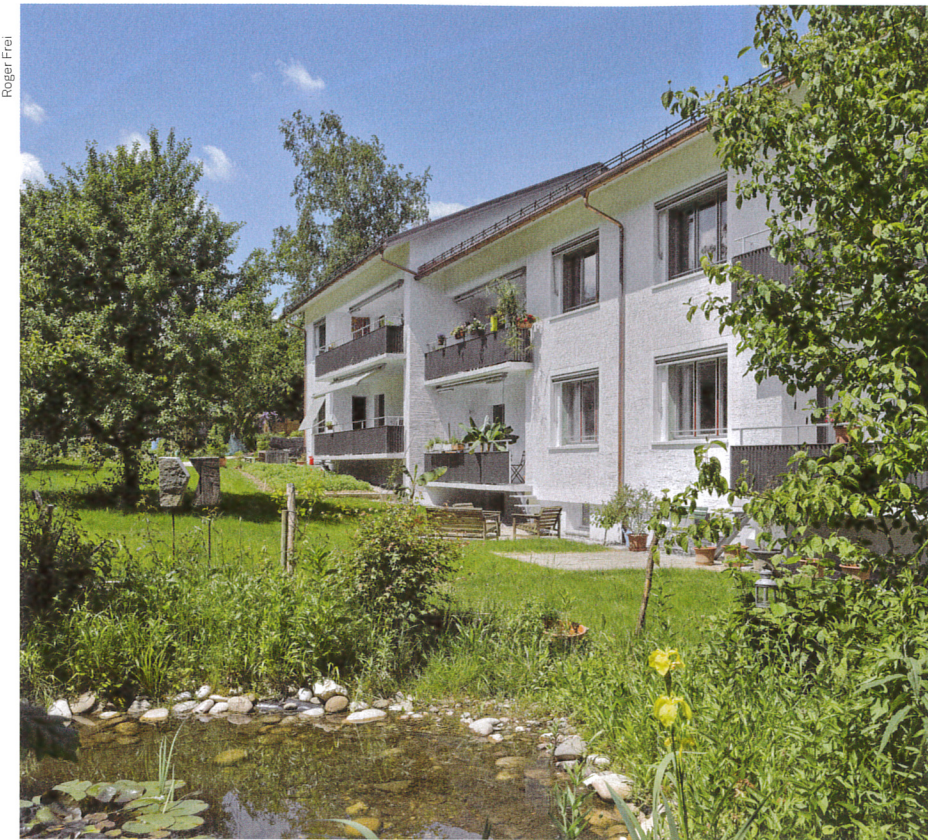
Den Architekten Husistein & Partner gelang eine vorbildliche Bilanz: Heute benötigt das Haus fast 90 Prozent weniger Energie.
